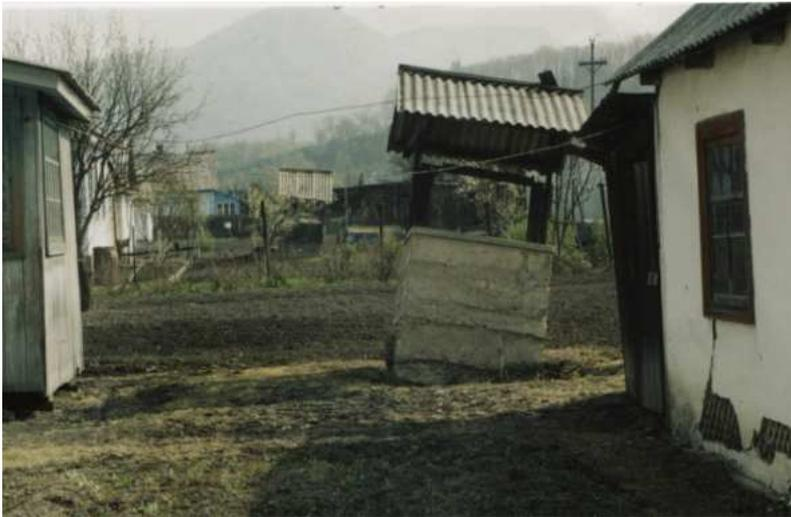
**Рис. 3.44. Деформация колодцев над выработанным пространством шахты «Авангард»**
